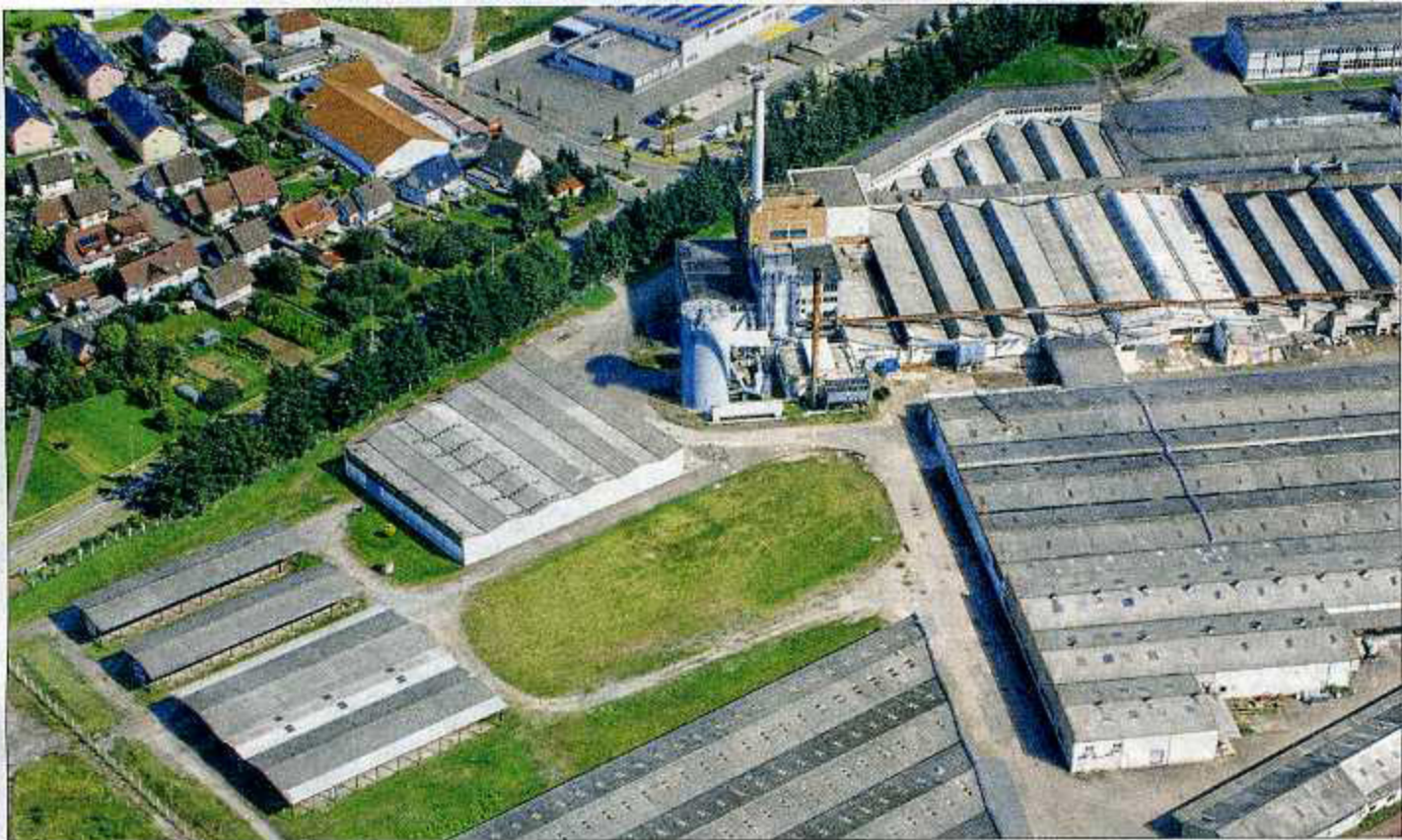
Im Sondergebiet »Kinzigpark III«, das unten links ausgewiesen wird, werden die längst nutzlosen früheren Hukla-Holztrocknungshallen abgerissen, damit nahe der inzwischen für große Feste genutzten Halle beim Kraftwerk ein Rewe-Markt gebaut werden kann. Oben in der Mitte ist der Edeka-Markt zu sehen.
